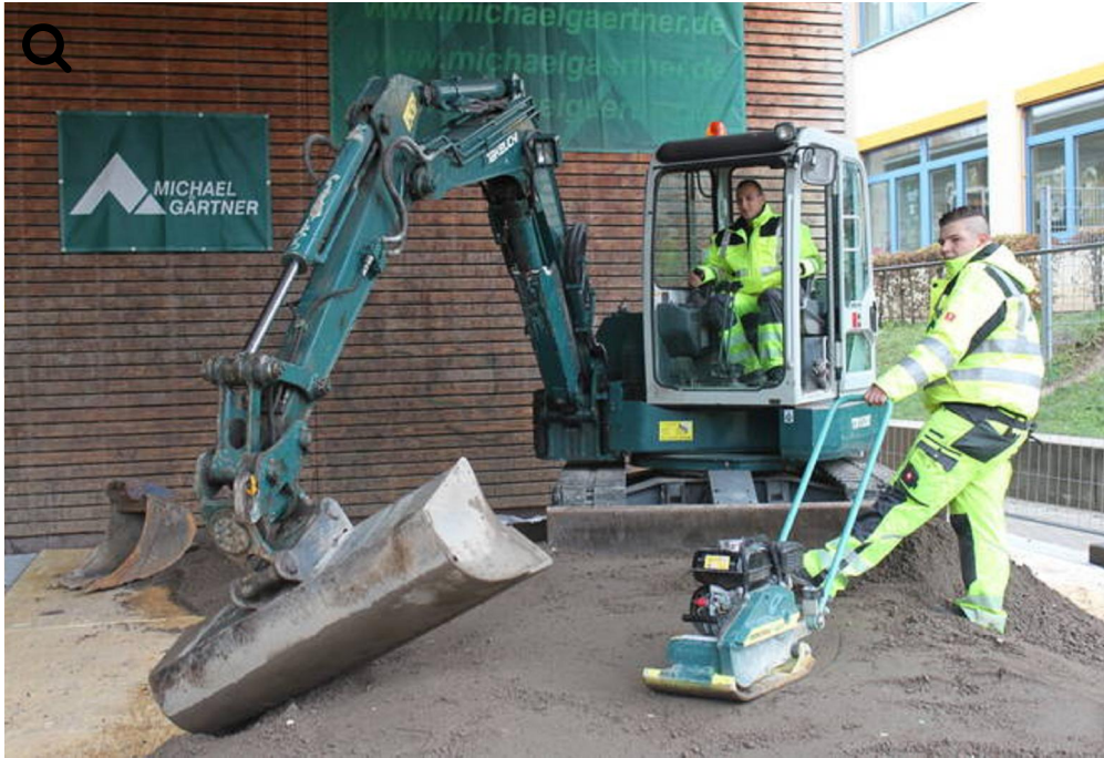
Bei der Firma Michael Gärtner geht's zur Sache: Mit einem Sechs-Tonner-Bagger wird ein Abwasserkanal ausgeschaufelt, der Kanal verlegt und dann alles mit dem Rüttler verdichtet.
